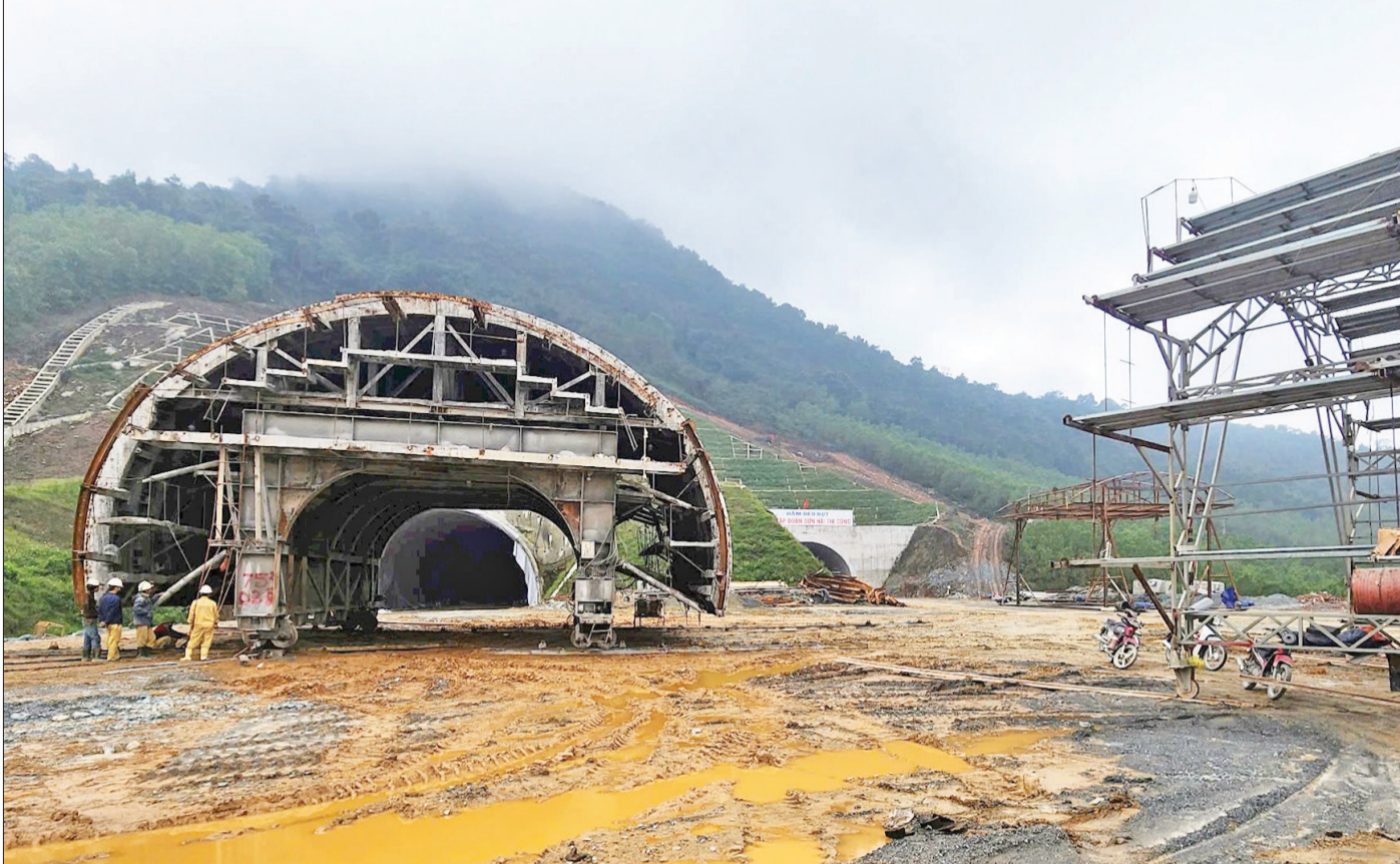
Kỹ sư, công nhân lắp ráp khung chống đỡ cửa hầm trái phía nam hầm Đèo Bụt.
